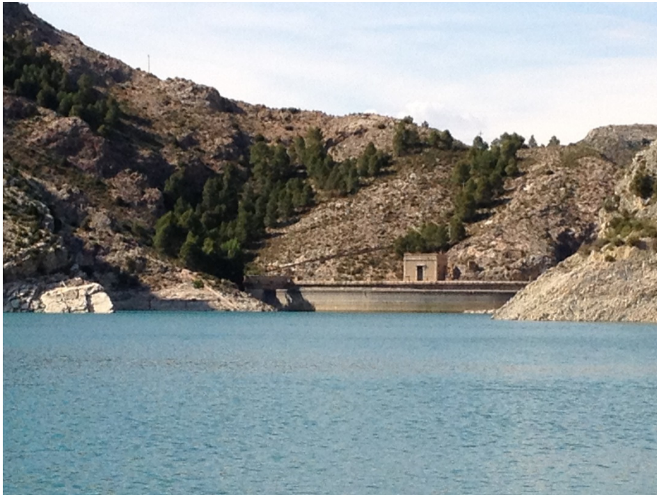
Figura 7. Vista de la presa del embalse
