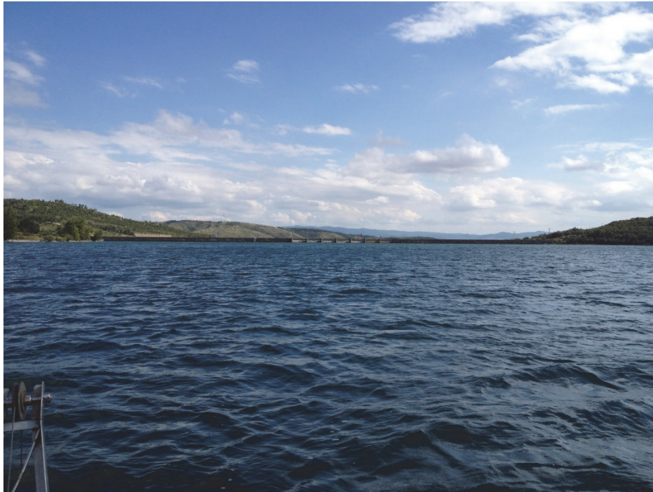
Figura 7. Vista de la presa del embalse
