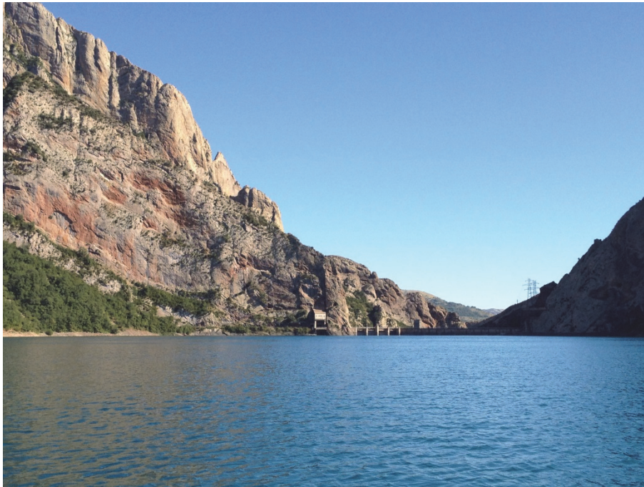
Figura 7. Vista de la presa del embalse
