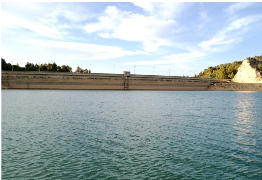
Figura 7. Vista de la presa del embalse
