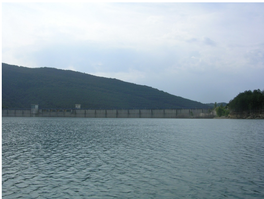
Figura 7. Vista de la presa del embalse
