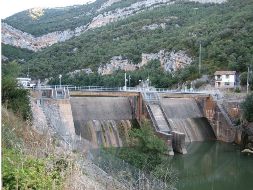
Foto 1: Vista de la presa del embalse
