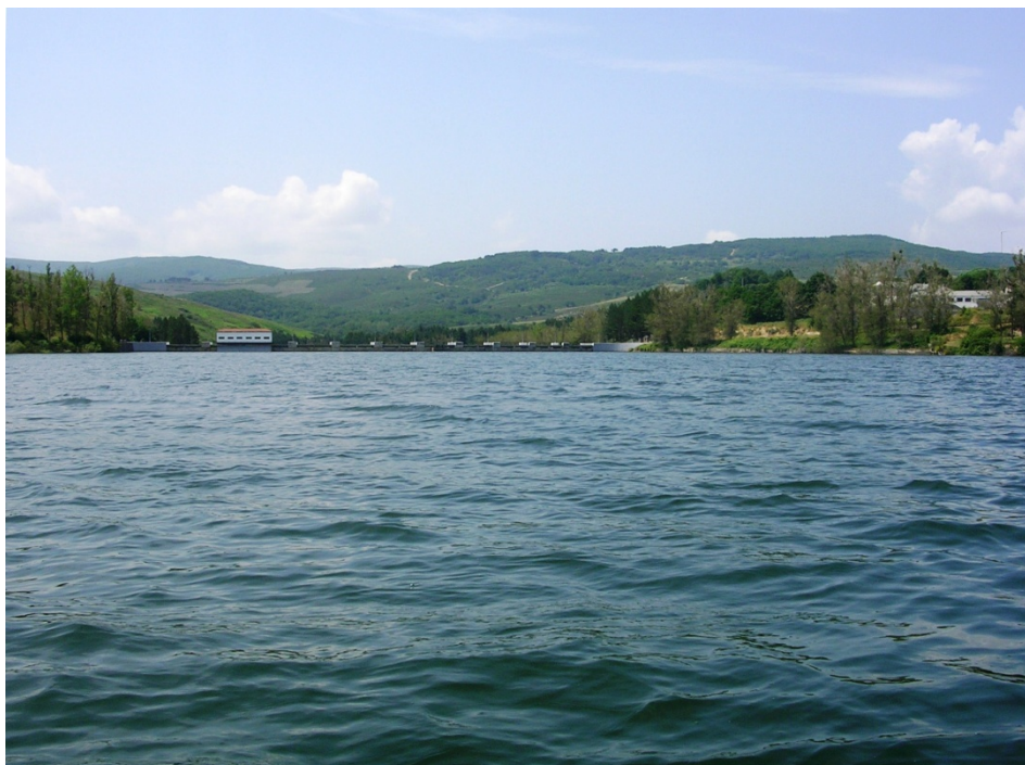
Figura 7. Vista de la presa del embalse
