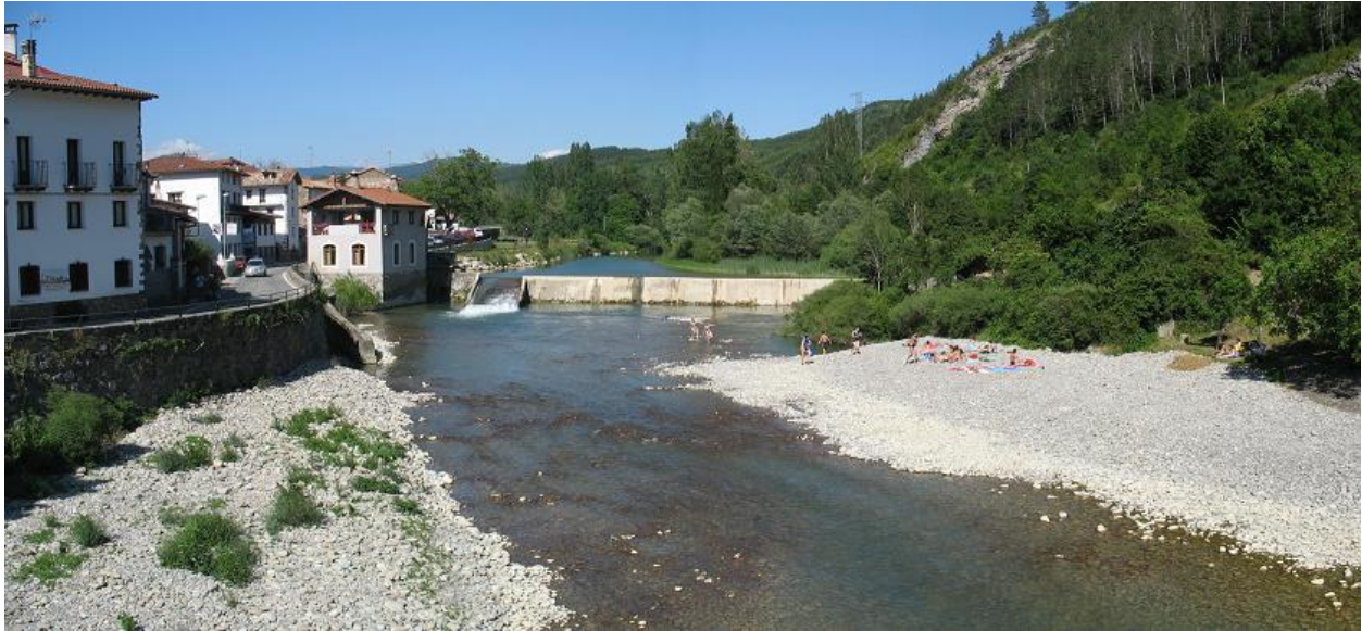
Figura 54-46. Azud en la localidad de Burgui.
