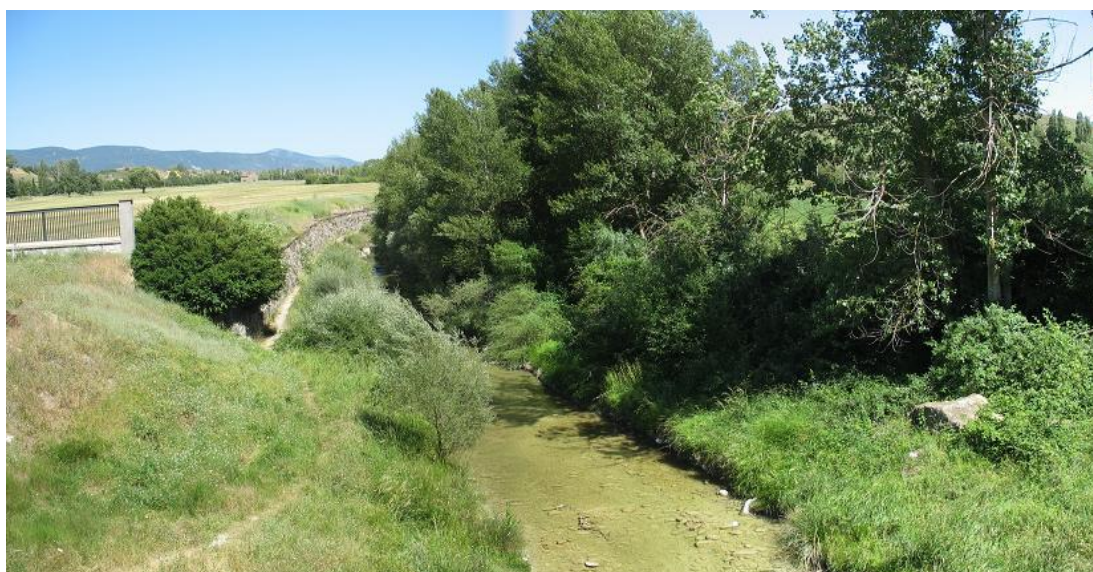
Figura 54-23. Defensas laterales y corredor ribereño limitado en las inmediaciones de Barós.
