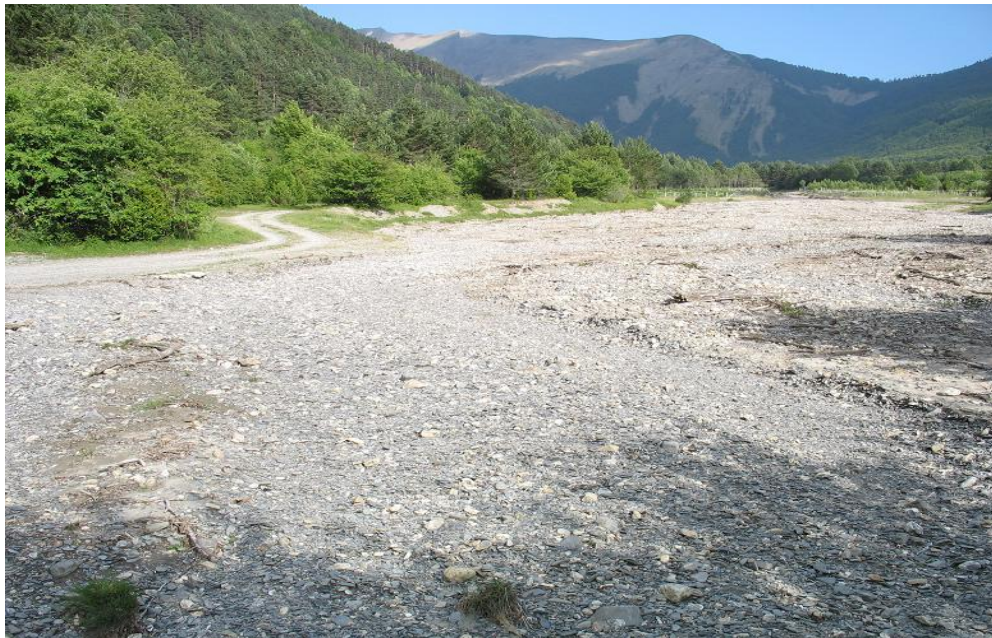
Figura 54-43. Dragado en el sector alto de la masa de agua.
