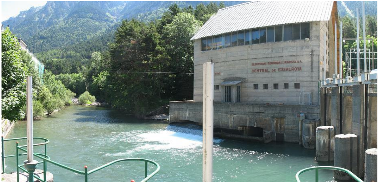
Figura 54-7. Salida de la central hidroeléctrica de Canal Roya y represa para derivación de caudales
