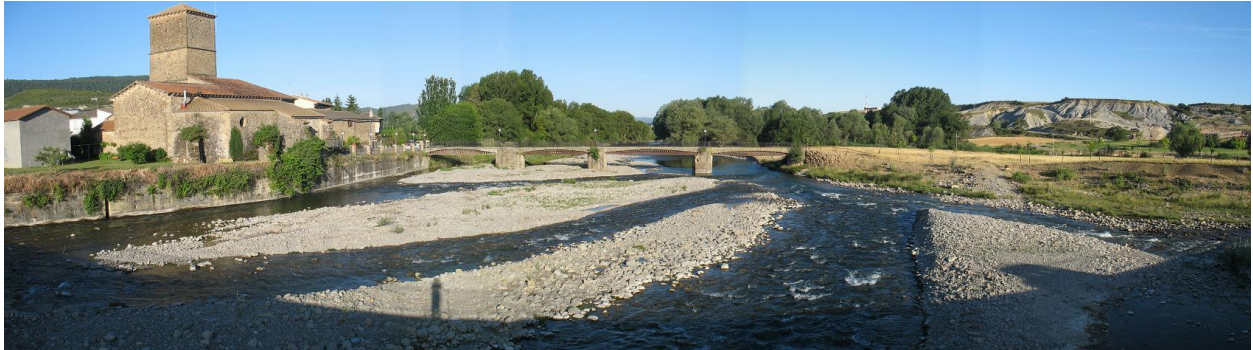
Figura 54-13. Amplio cauce trezado y defensas de margen en Santa Cilia de Jaca.
