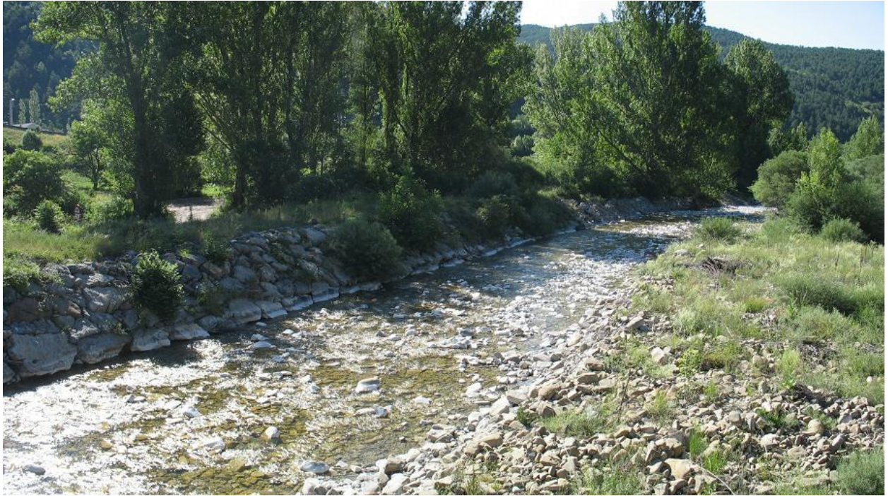
Figura 54-33. Defensas laterales en el cauce medio del río Osía.
