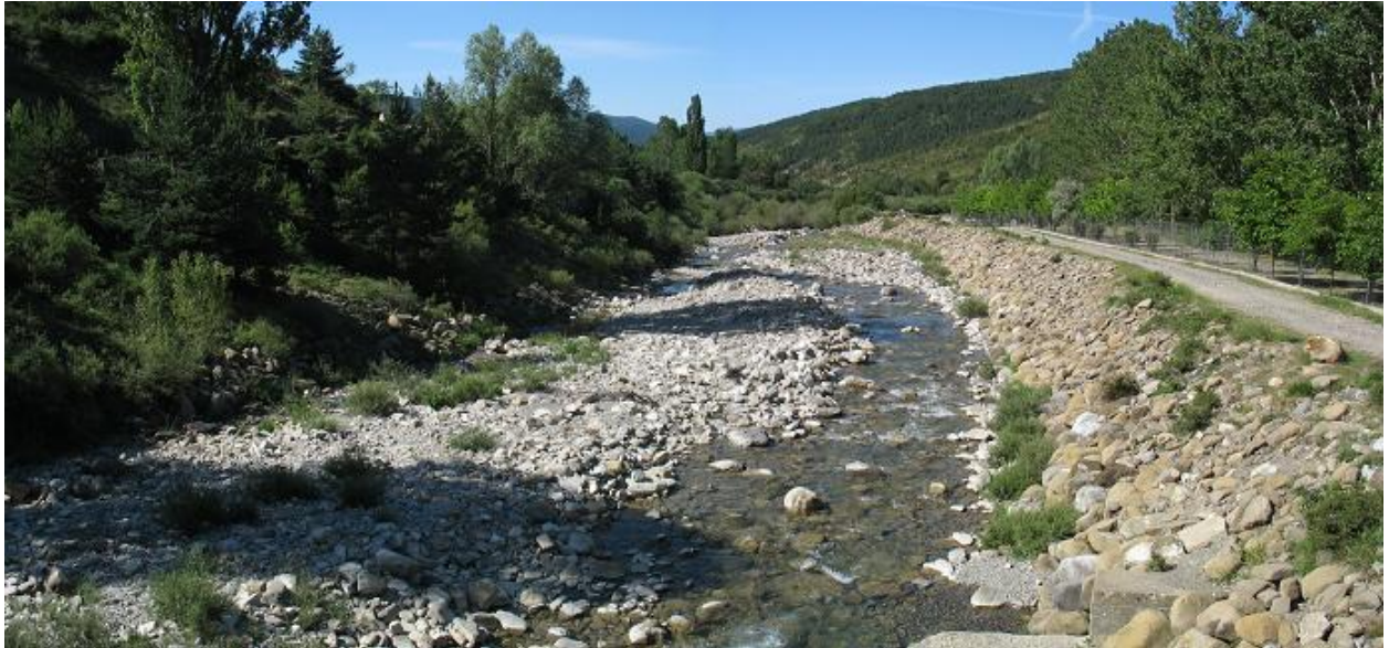
Figura 54-26. Defensas laterales en el río Estarrún aguas arriba de Aísa.
