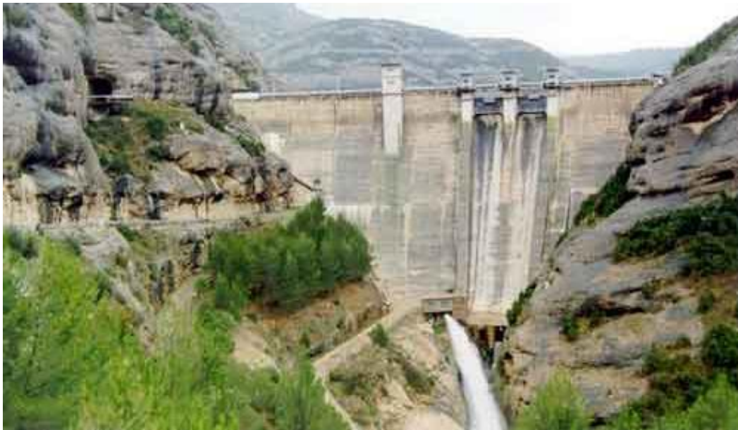
Figura 25-7. Presa del embalse de Vadiello (CHE).
