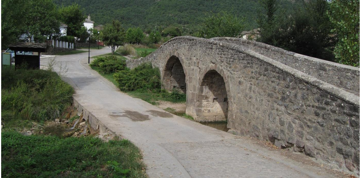
Figura 25-5. Puente y vado de Nocito.
