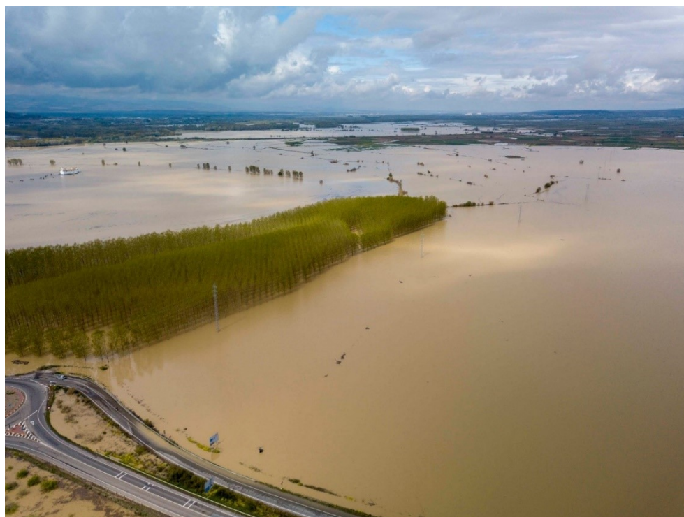
Figura 136. Imagen de dron de la crecida extraordinaria del río Ebro en abril de 2018 (Fuente: CHE).
