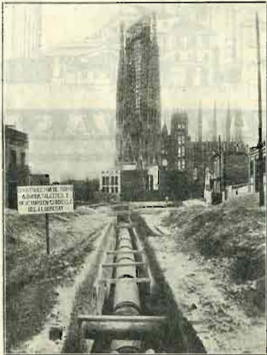
Tubería de 1,00 m. de diámetro.
