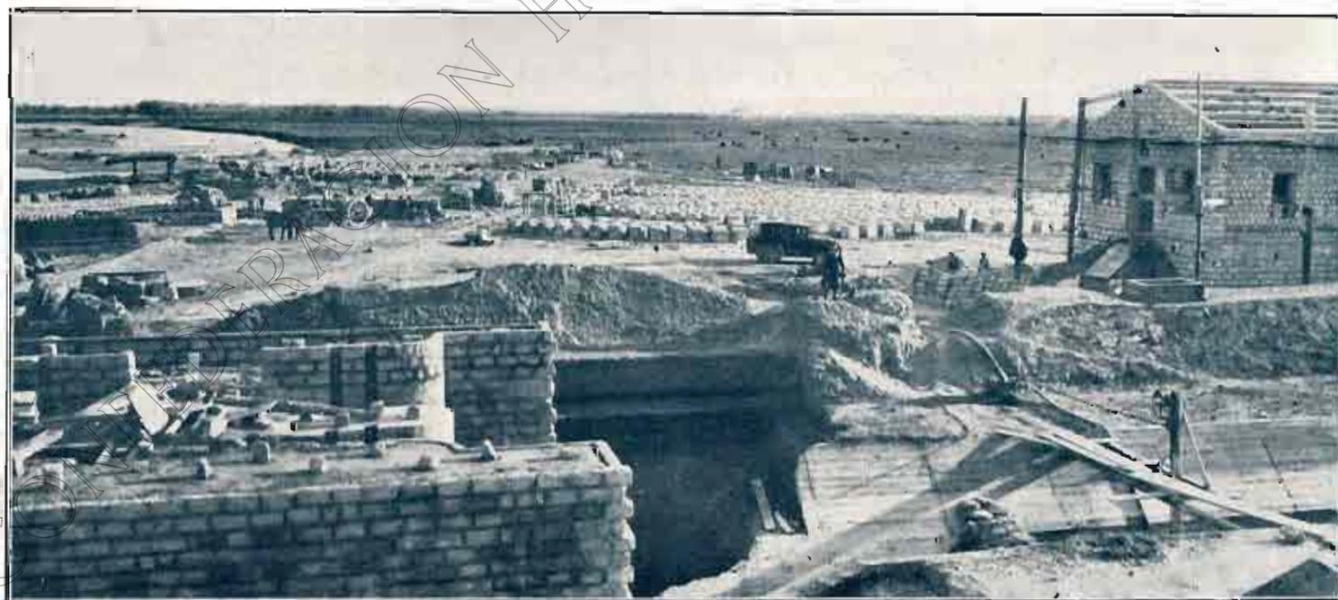
VISTA DEL TALLER DE BLOQUES PARA CONSOLIDACIÓN DE LA PRESA. A LA DERECHA, EL ALMACÉN, EN CONSTRUCCIÓN
