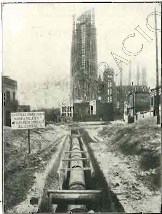
Tubería de 1,00 m. de diámetro.
