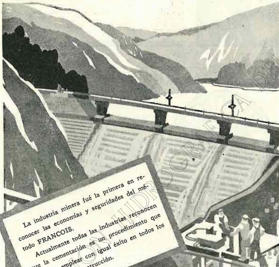
**E**L sistema de cementación FRANCOIS ha hecho abandonar la construcción de zanjas impermeables como medio de evitar que el agua filtre alrededor o debajo de una presa. Con el sistema de cementación FRANCOIS se consigue formar pantallas subterráneas, taponando toda clase de filtraciones en un tiempo mínimo. Sean grandes o peque-
