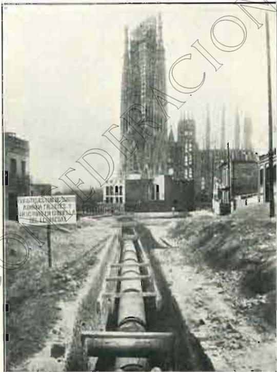
Tubería de 1,00 m' de diámetro.
