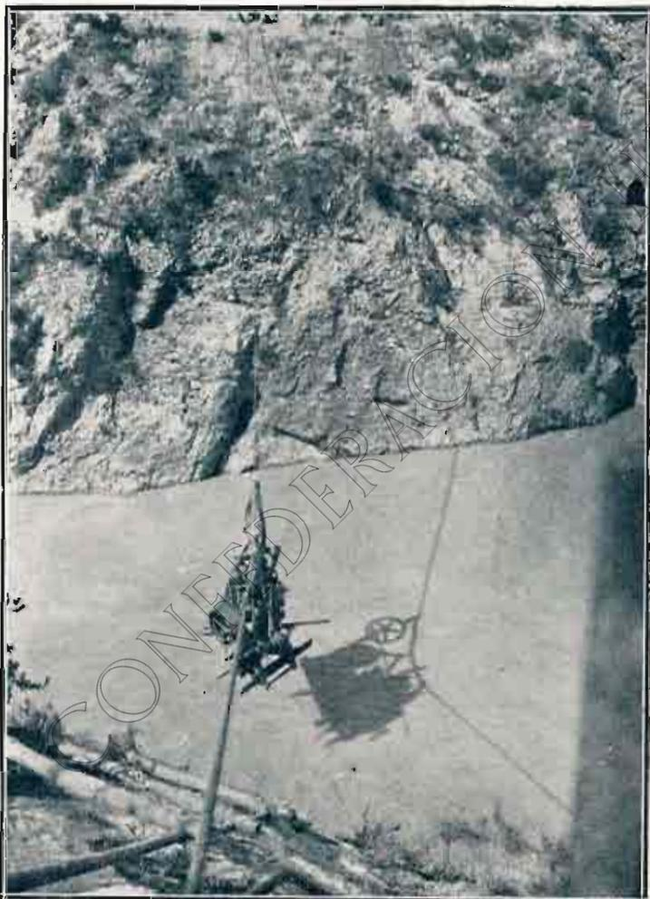
LA SONDA DE LA ANTERIOR FOTOGRAFÍA, SUSPENDIDA POR UN CABLE DESPUÉS DE LA CRECIDA QUE ARRASTRÓ LA PLATAFORMA
