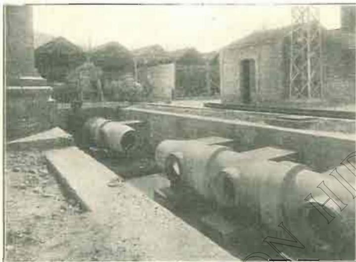
Colector de 1,00 m. con injertos de 0,60 m. — Presión 12 Kg./cm<sup>2</sup>
