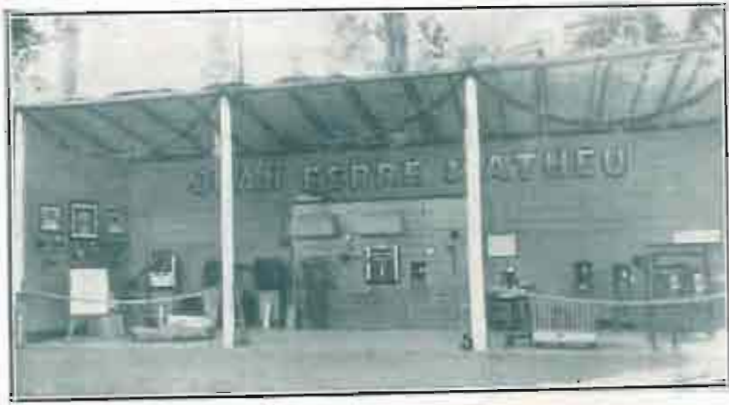
MAGNÍFICA INSTALACIÓN DE HORNOS Y MATERIAL DE PANIFICACIÓN DE LA CASA FERRÉ MATHIEU, DE LÉRIDA
