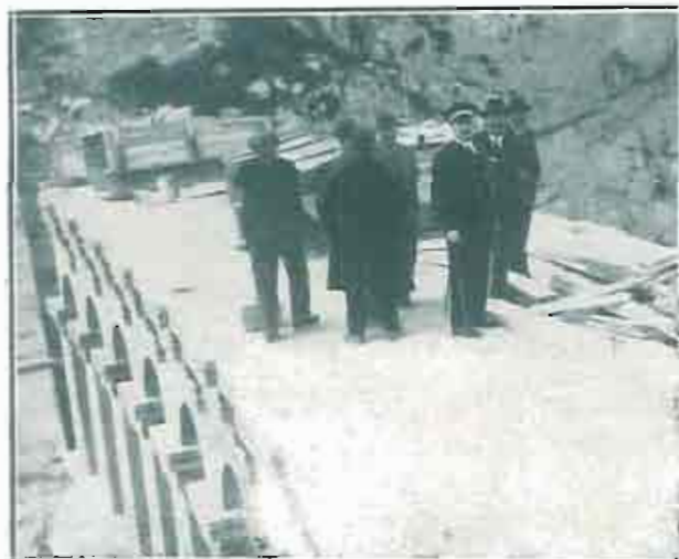
LAS AUTORIDADES Y TÉCNICOS DE LA CONFEDERACIÓN VISITANDO LAS OBRAS DEL PANTANO. (Fotografía obtenida cuando se hallan sobre la coronación de la presa)
