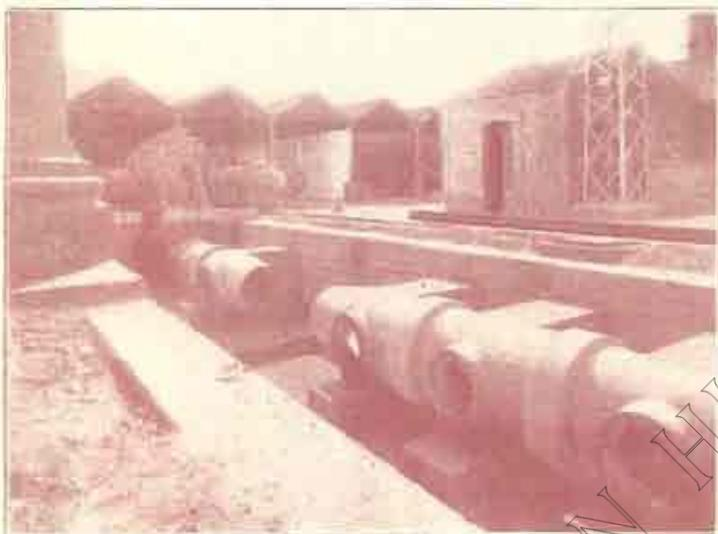
Colector de 1,00 m. con inierros de 0,60 m. — Presión 12 Kg/cm<sup>2</sup>
