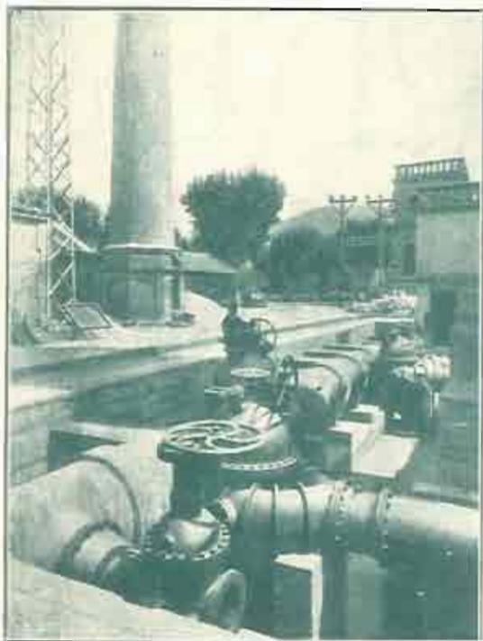
Colector de un metro, con empuñes para presión de 12 Kg./cm<sup>2</sup>
