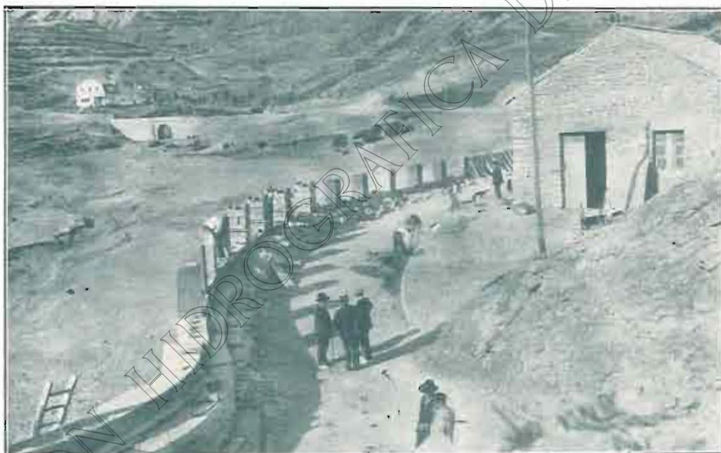
OBRAS QUE HA SIDO PRECISO REALIZAR EN LA CARRERETA PARA EVITAR QUEDARSE EMBARRADA CON MOTIVO DEL RECHECIMIENTO DE LA PRESA
