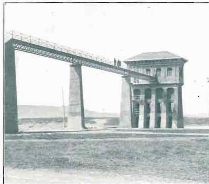
Caseta para el mecanismo de compuertas en el Pantano de la Sotomera.
