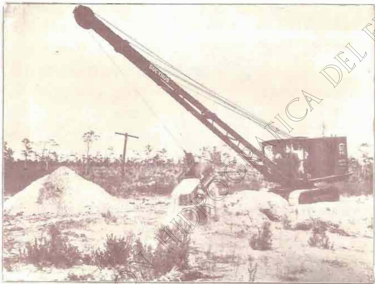
El costo de combustible es solamente  $\frac{1}{3}$  a  $\frac{1}{4}$  del de una excavadora de gasolina.
