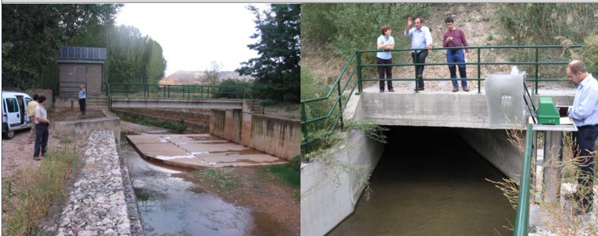
Figura 102. Imágenes de visitas de campo en la cuenca de los ríos Jalón y Jiloca
