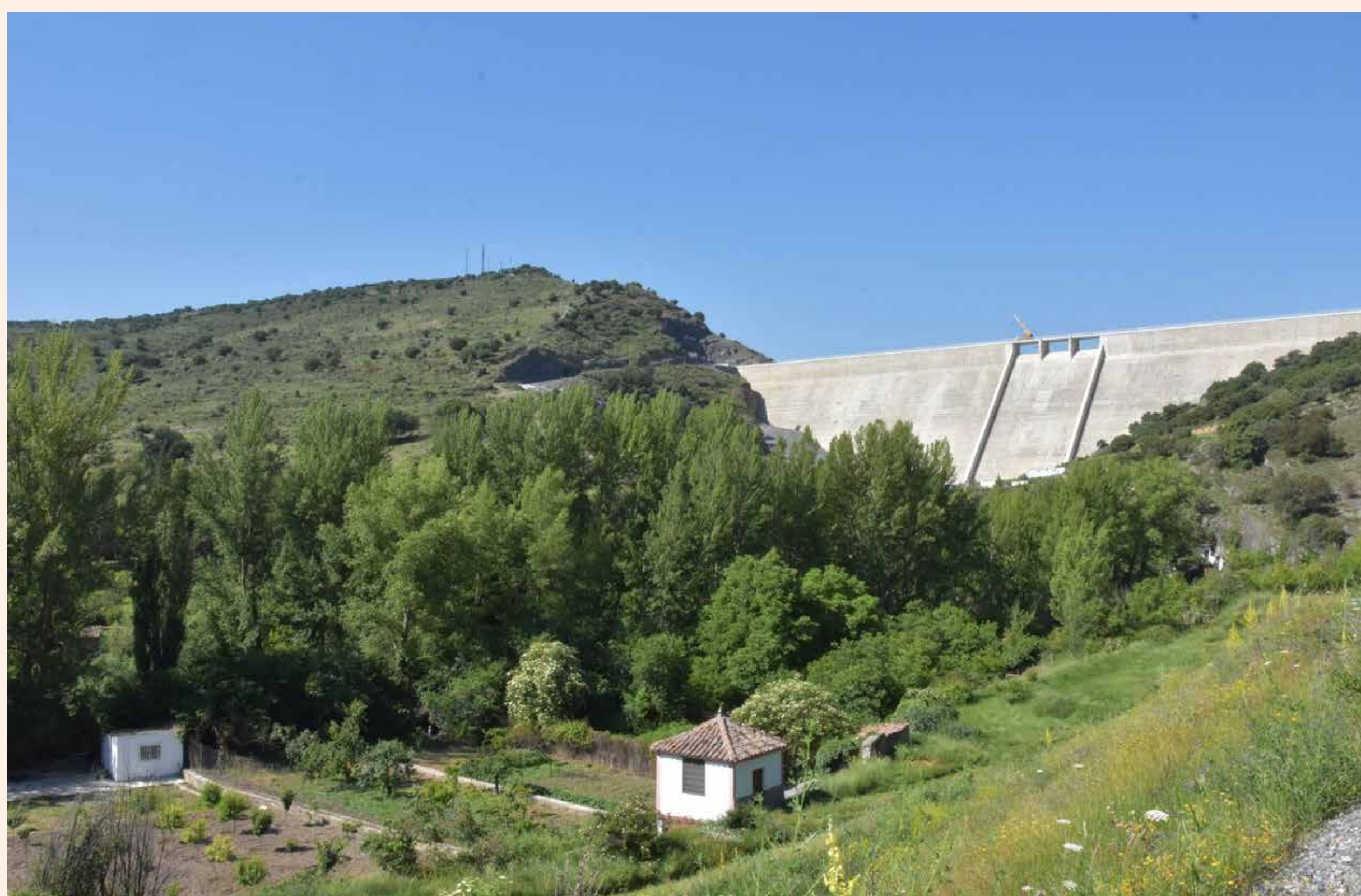
Presa de Enciso en el río Cidacos (La Rioja). Un ejemplo de infraestructura recientemente construida por la CHE con financiación del MITECO
