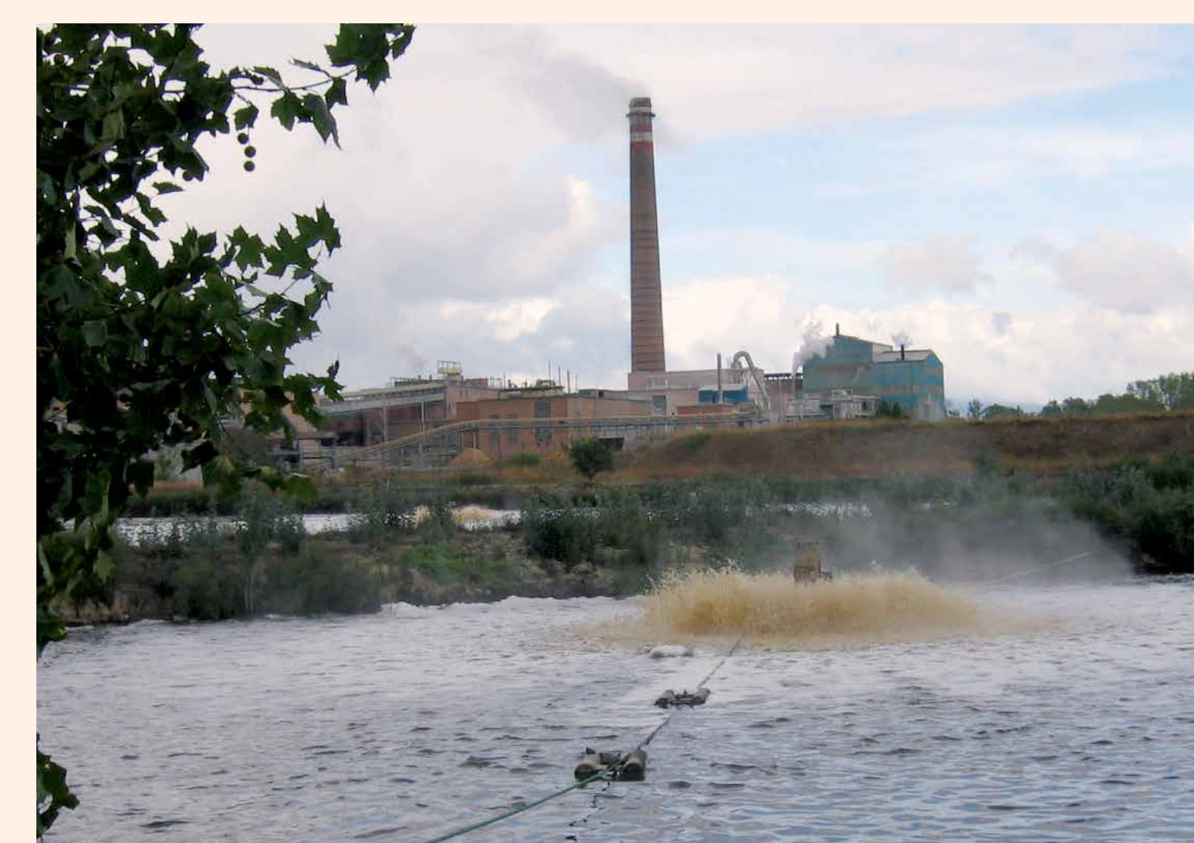
La relación entre la administración hidráulica y las industrias ha sido fundamental para garantizar una producción sostenible. EDAR de una industria papelera de Miranda de Ebro
