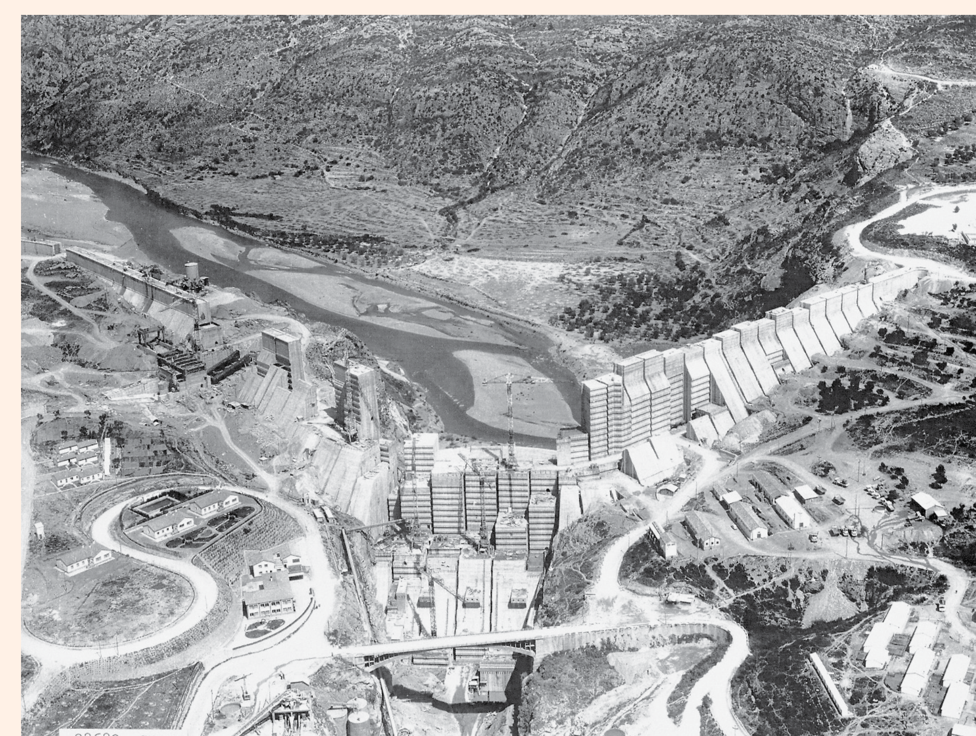
El desarrollo económico de la cuenca ha tenido como uno de sus ejes el incremento de la regulación auspiciada por la Confederación, lo que ha permitido garantizar los usos del agua - Construcción de la presa de El Grado en el río Cinca en 1964
