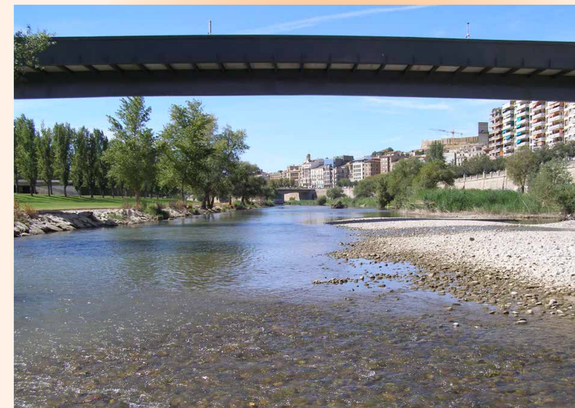
Actuación de protección en el tramo urbano del río Segre en Lleida con motivo de la gran riada de 1982
