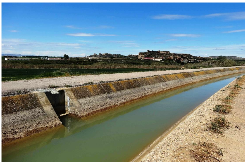
Figura 55. Imagen del canal de Los Monegros (Fuente: CHE).
